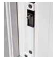
Verrou de maintien bas suivant dimension (à partir de 5 vantaux par côté)
